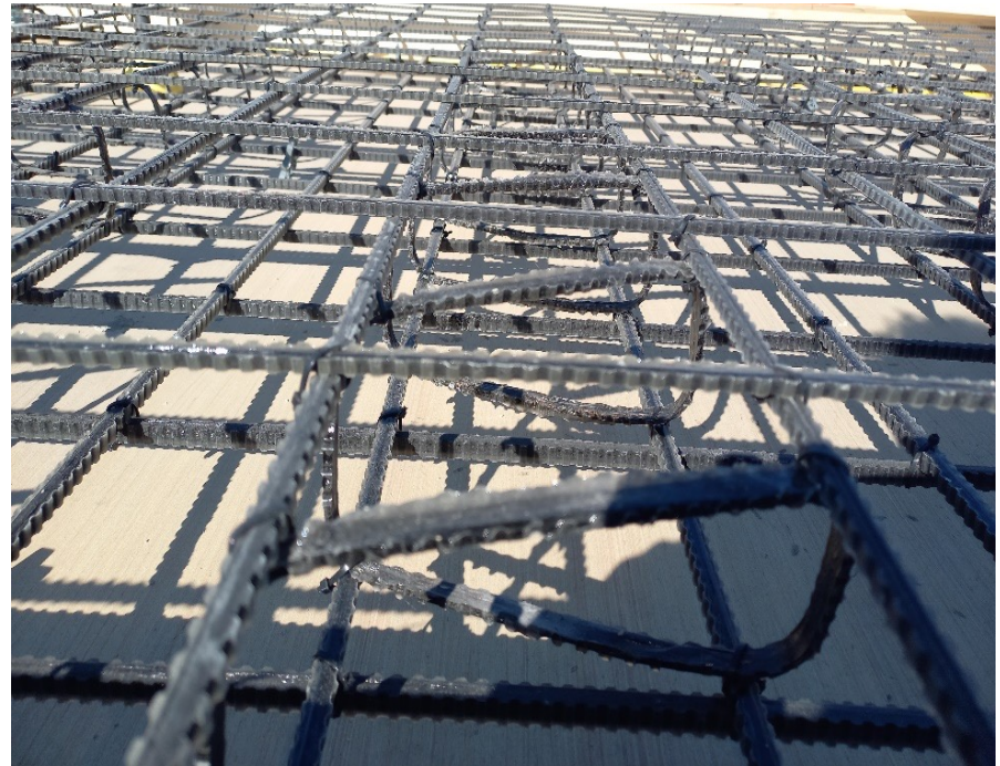
Basaltfaserstabbewehrung der Recyclingbeton-Bodenplatte
