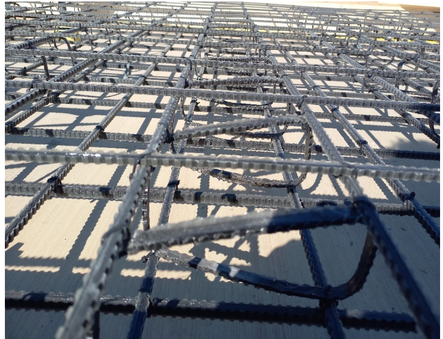
Basaltfaserstabbewehrung der Recyclingbeton-Bodenplatte
