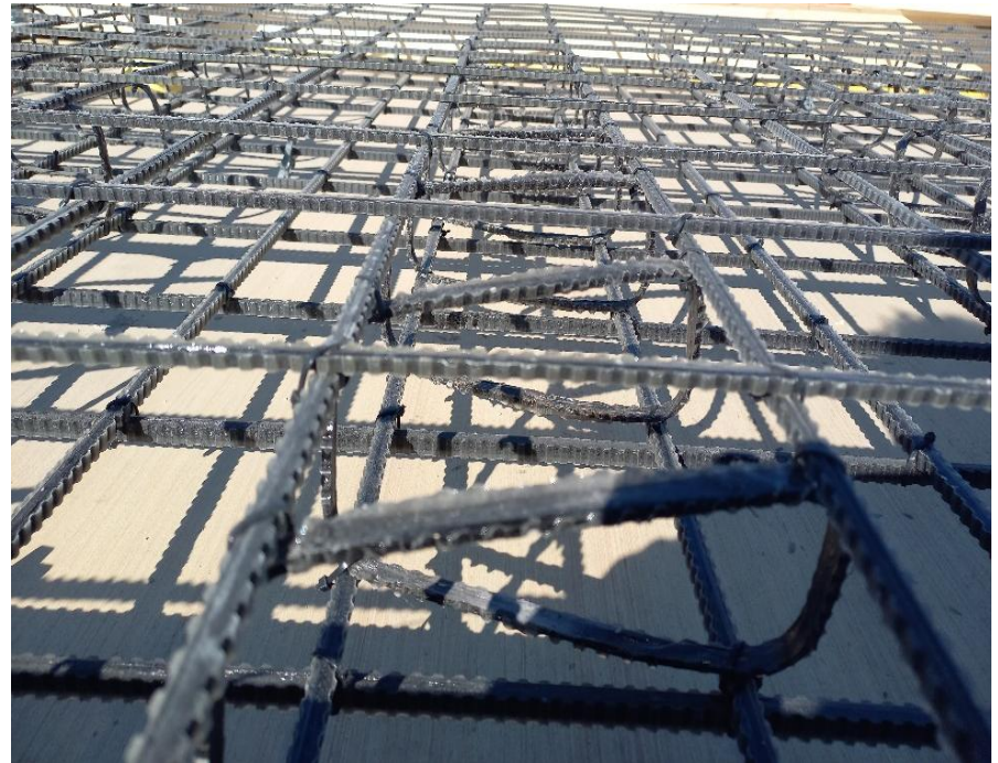
Basaltfaserstabbewehrung der Recyclingbeton-Bodenplatte
